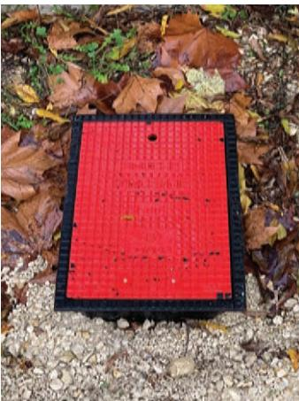
Les travaux de voirie ont permis de moderniser le réseau de défense incendie avec le remplacement de bornes d'incendie par des bouches d'incendie (ci-contre).
