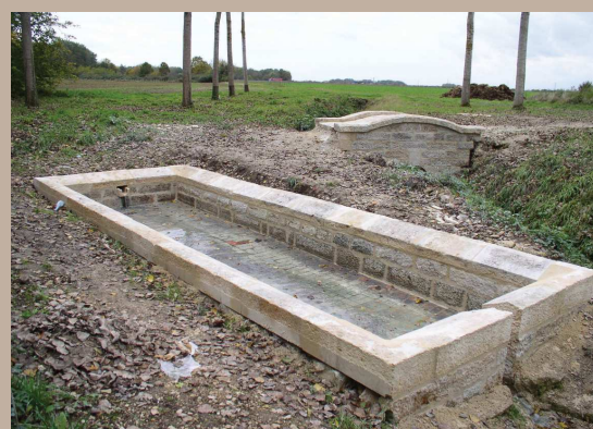
La maçonnerie du lavoir terminée
